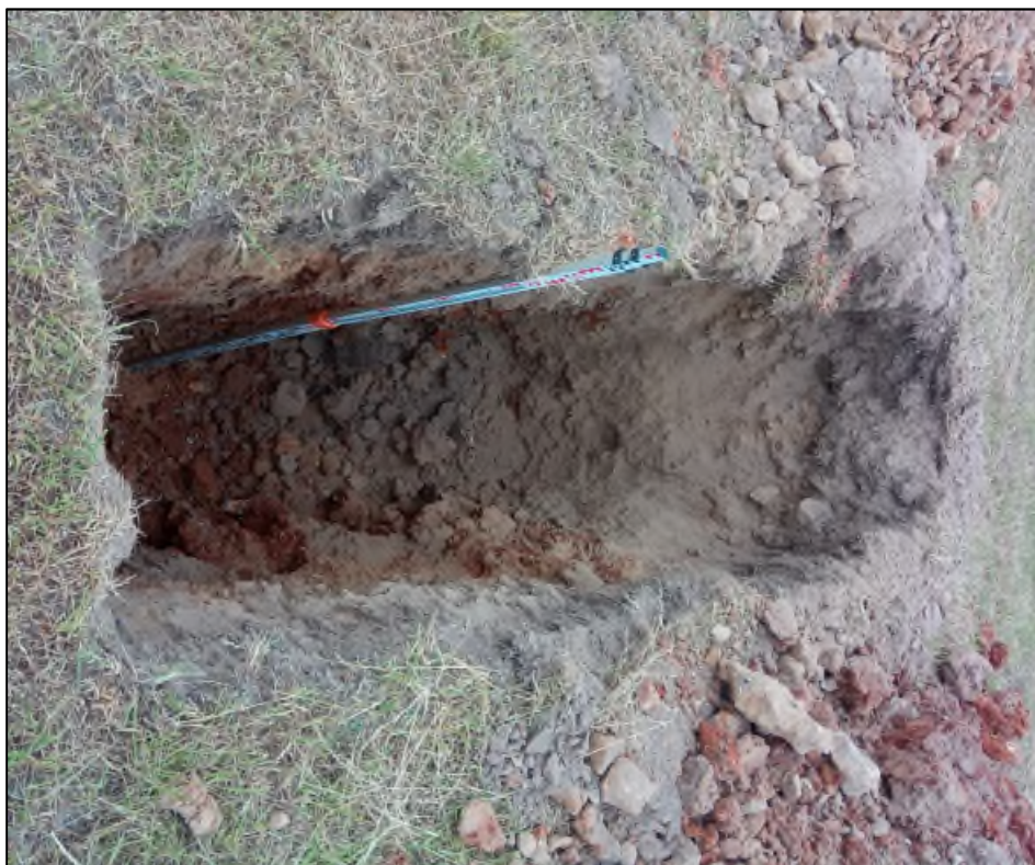
Photographie du sondage PM7
