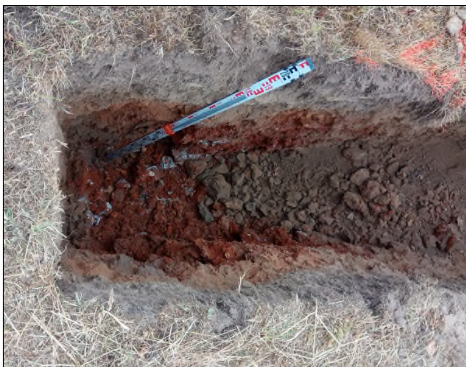
Photographie du sondage PM10
